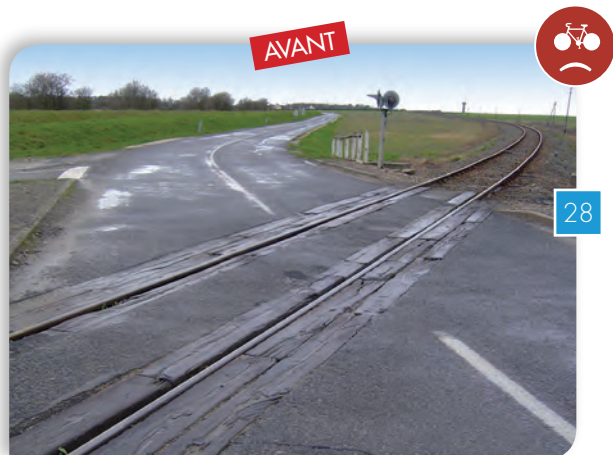
Joint en bois entre la voie et le bitume de la route en très mauvais état, sur une voie non perpendiculaire à la route (chute par glissade due au bois mouillé et blocage de route).
