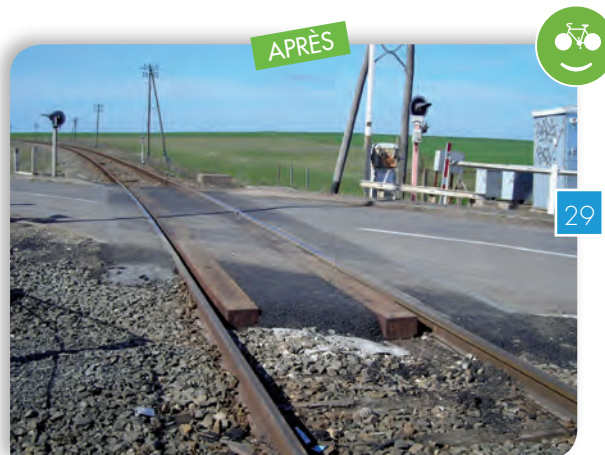
Joint en bois entre la voie et le bitume de la route en très mauvais état, sur une voie non perpendiculaire à la route (chute par glissade due au bois mouillé et blocage de route).
